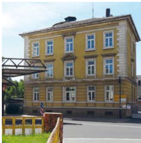
Abb. links Schule und Internat der Obstbaumeister- und Baumwartausbildung 1952/54 in Wurzen, Fotos: (alle dieses Artikels) W. Schuricht Abb. rechts 1901 errichtetes Schulungsgebäude im damaligen landwirtschaftlich-botanischen Garten, ab 1957 Obstversuchsstation Wurzen
